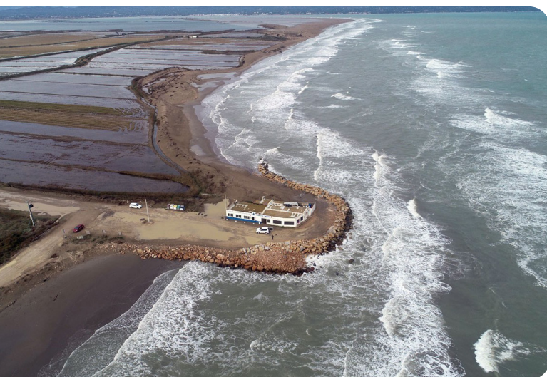
Estructura costera rígida protegiendo el restaurante Los Vascos - Foto: Taula de Consens, Aguaita.cat
