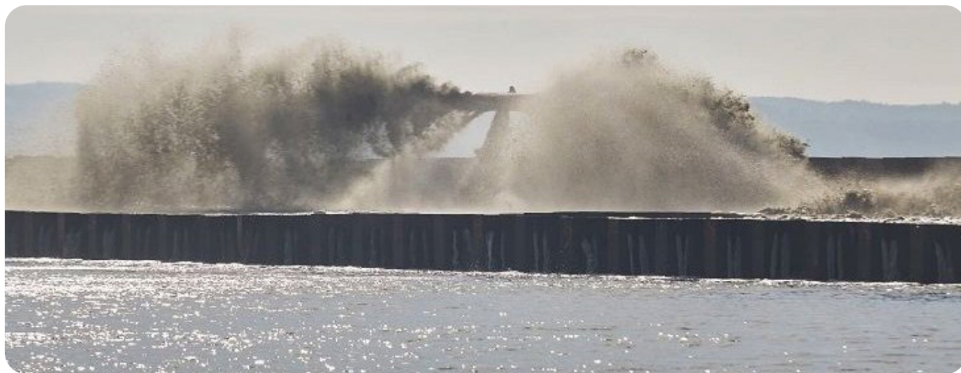
Wyspa w trakcie budowy
